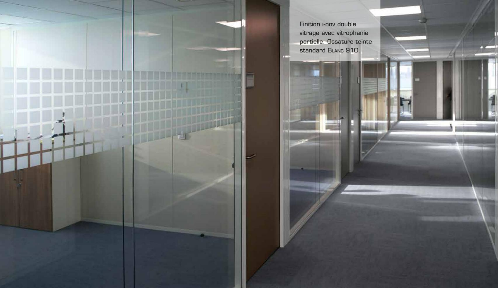
Finition i-nov double vitrage avec vitrophanie partielle. Ossature teinte standard BLANC 910.
